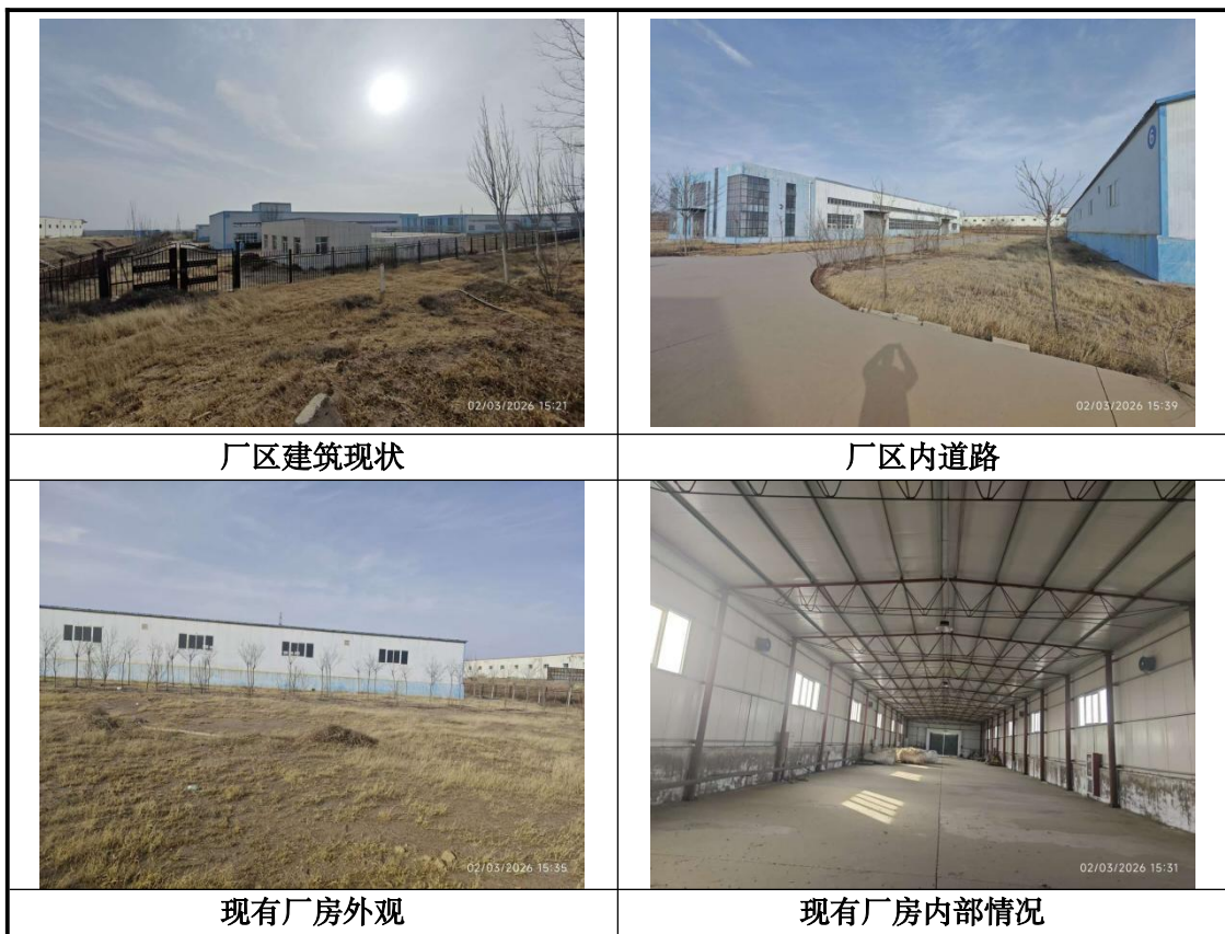
图 2-6 宁夏中科新建环保科技有限公司厂区建设现状影像资料
