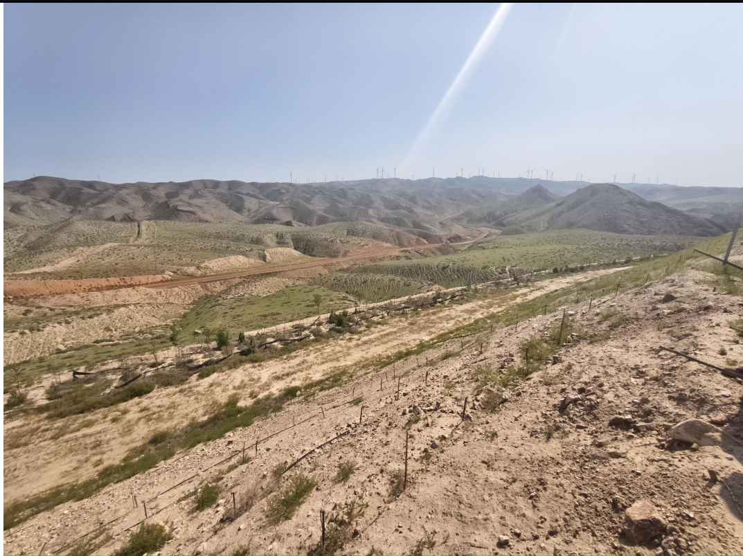
图 3-11 +1425m 平台外侧区域外侧边坡恢复治理
