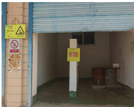
危废暂存间外部
