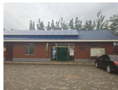
2-34 德盛村卫生室
