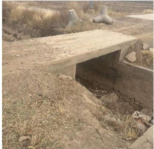
长鸣渠 3#生产桥
