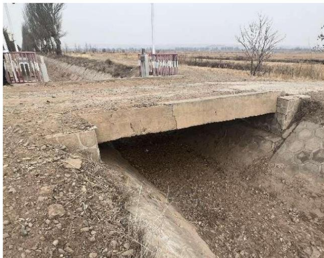
长鸣渠 1#生产桥
