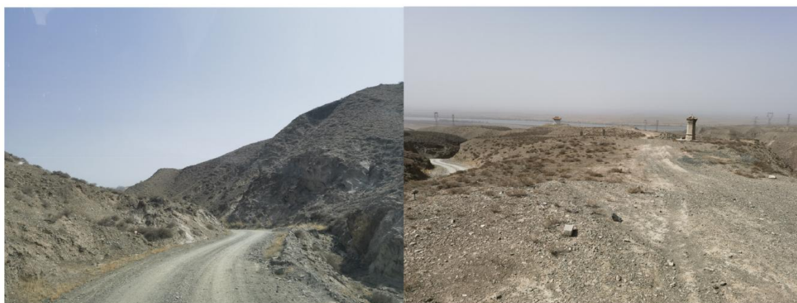
图2-4 支线三路面现状图
