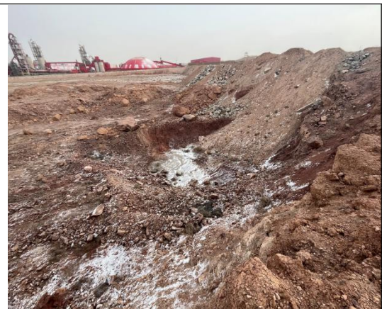
B-8 区边坡现状照片
