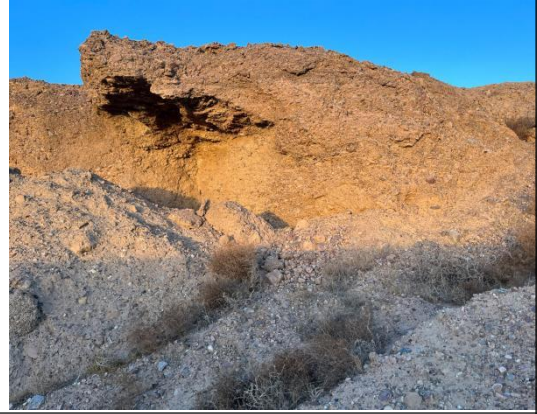
A-4区边坡危岩体现状照片
