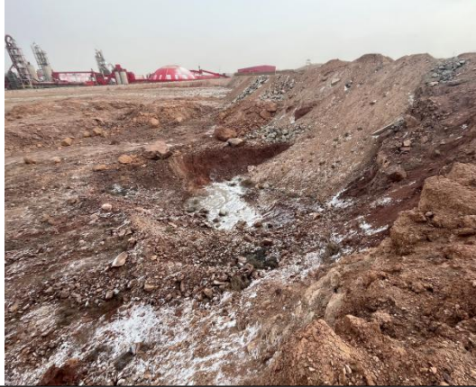
B-8 区边坡现状照片
