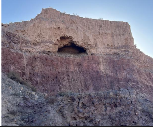
C-3 区 BP30 边坡现场照片
